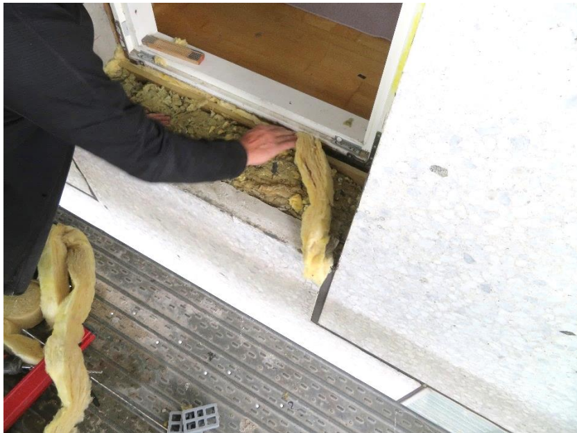
Foto 3: Supplerende fugefilt omkring vinduer.
