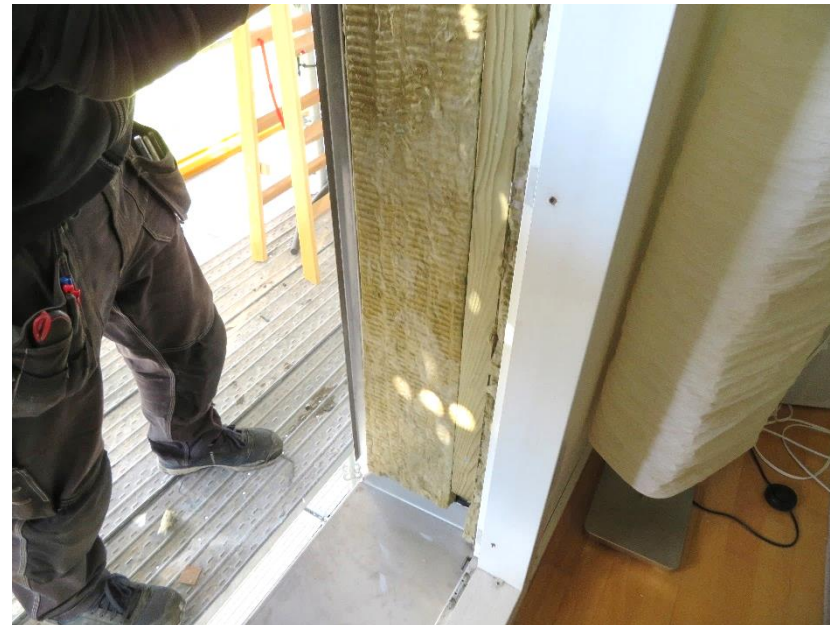
Foto 10: Isolering af false.
