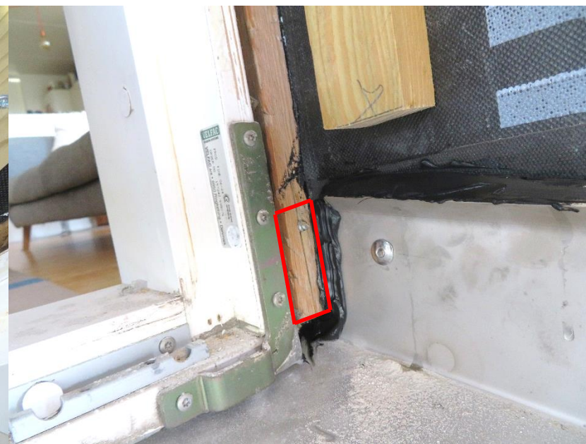
Foto 8.2: Supplerende fuger ved bunden mod trælister ved karm. Rødt udsnit afskæres og udfyldes med elastisk fuger.
