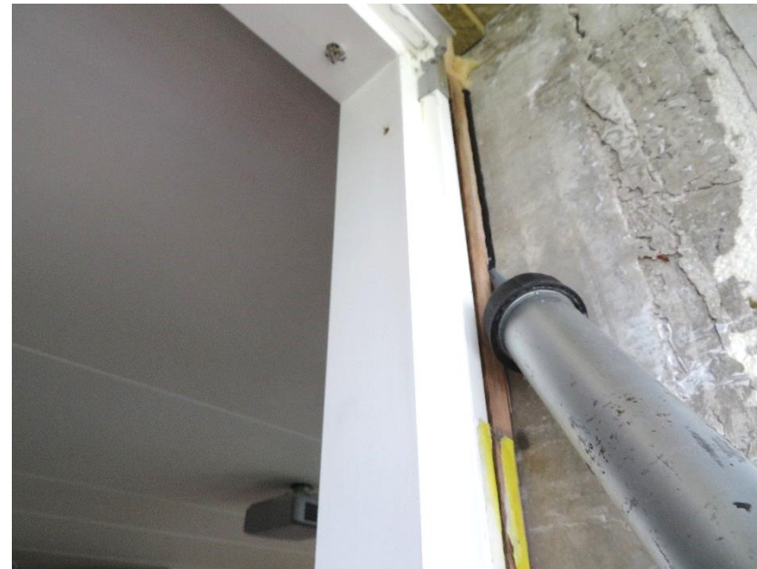
Foto 4: Fugetætning mod betonfalse.
