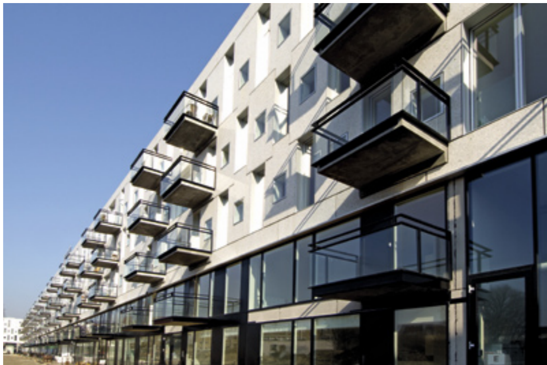
Emaljehaven strækker smukt sin 18 meter høje og 220 meter lange terrazzo-facade i København NV. Tinglev Elementfabrik A/S har leveret både vægge og dæk til hele nybyggeriet fra kælder til tag, mens Spæncom A/S har leveret søjler og bjælker til byggeriet Emaljehaven.
